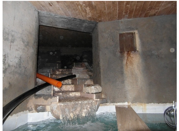
Fig.3 – Particolare dell'interno dell'opera di captazione.
