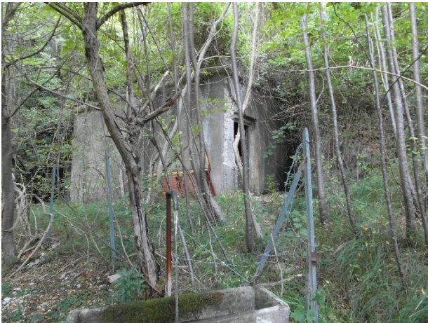
Fig.2 – Sorgente Acqua del Ciliegio: ingresso al bottino di presa.
