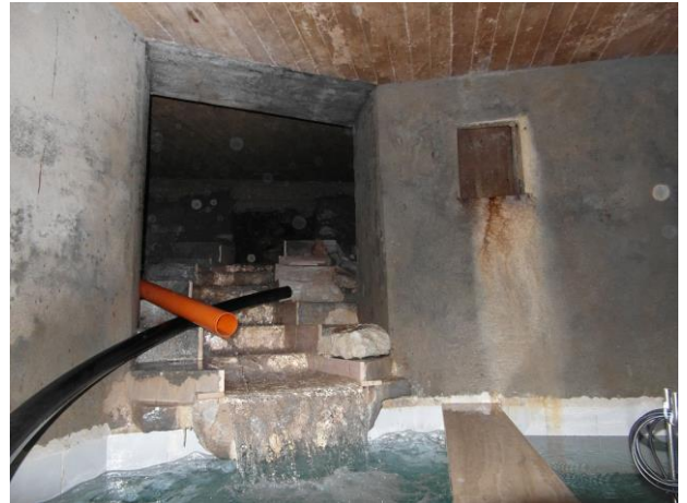
Fig.7.3 – Particolare dell'interno dell'opera di captazione.
